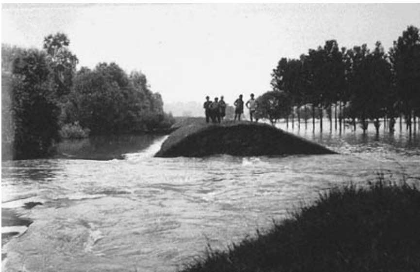
Bild 1: Deichbruch am Oberrhein im Bereich Karlsruhe (Wasserwirtschaftsamt Karlsruhe)
